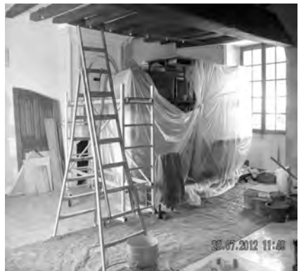
Travaux au prieuré été 2012
