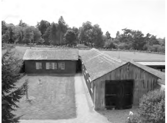
Préfabriqués situés devant le couvent à supprimer ou à aménager
